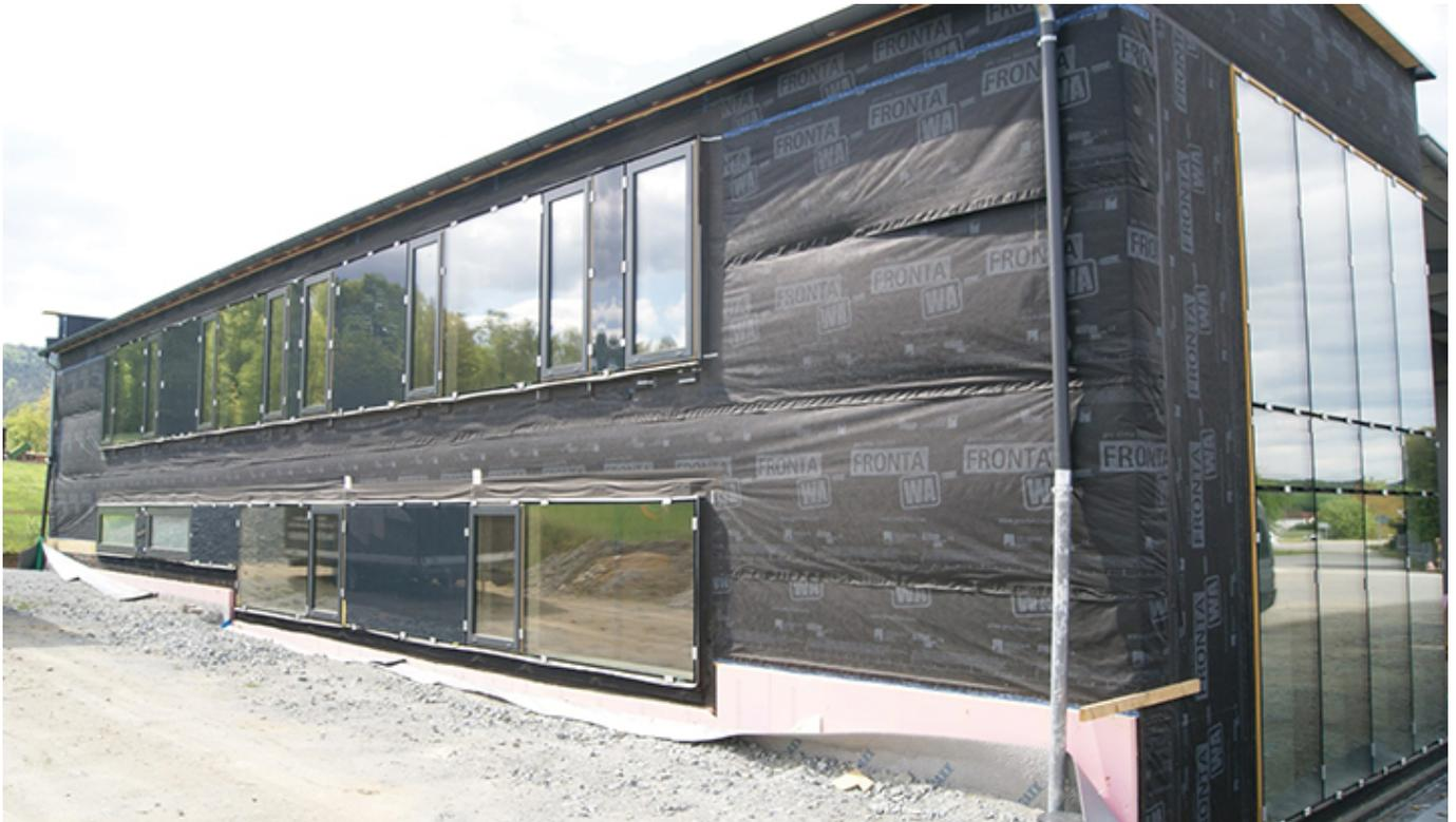
window.respimage && window.respimage({ elements: [document.images[document.images.length - 1]] }); Bürogebäude aus Massivholz mit Dämmung ohne Fassadenverkleidung
