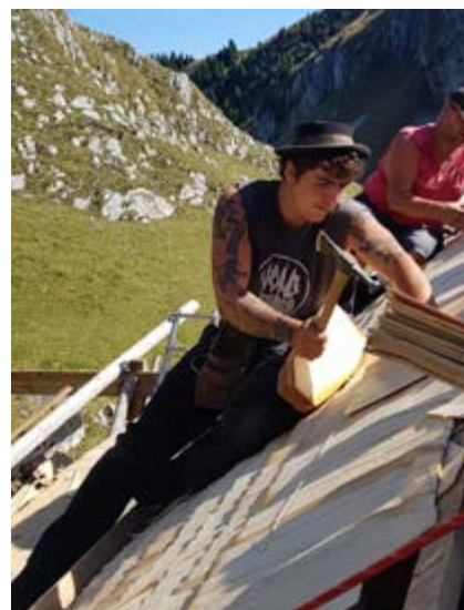
Leo Bartek bei Schindelarbeiten am Dach
