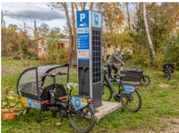
Solarstrom für Pedelecs und Lastenräder. Bei Bedarf liefern die netzgebundenen Ladesäulen auch bei Regenwetter Strom.
