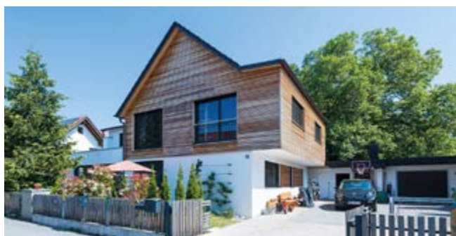
Modernisierung eines Bestandsgebäudes mit Anbau in massiver Holzbauweise. Quelle Bilder: Pohmann
